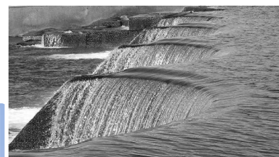
神戸堰（S3建設）RCアーチ構造
