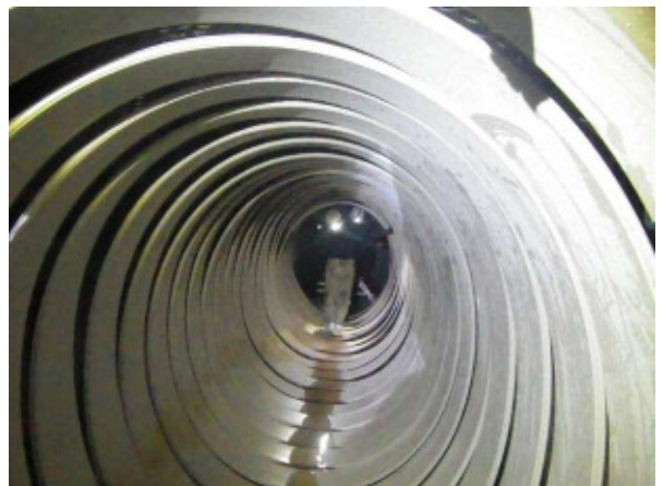
八戸川第一発電所 導水路補修工事
