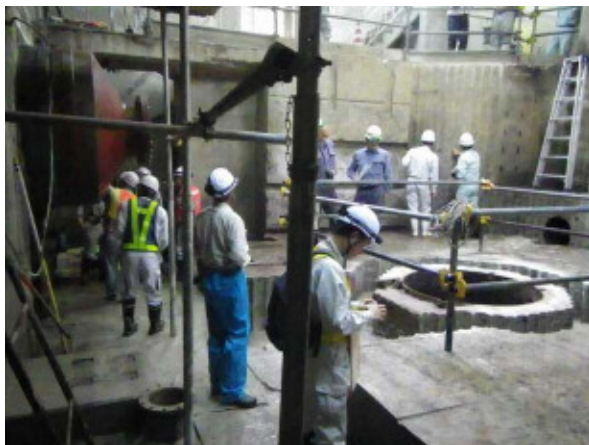
八戸川第一発電所 発電所基礎工事
